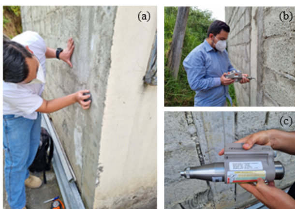
Fig. 3: Ensayos realizados para determinar la resistencia a la compresión del hormigón. (a) Preparación de la superficie, (b) Medición de la resistencia, (c) Esclerómetro utilizado.
