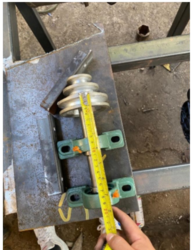
Fig. 14: Toma de medidas para colocación de segunda polea Nota: Elaborado por el autor
